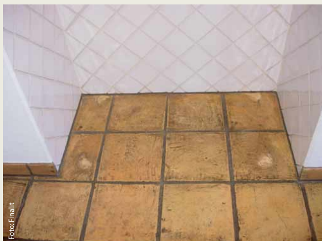
Cotto lebt: jede Art von Schmutz und Verunreinigung haftet in den deutlich sichtbaren verschiedenen Schichten auf der Oberfläche.
