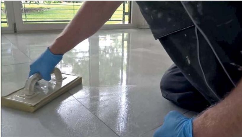
Leichtes, rückstandsfreies Abwaschen eines Reaktionsharzmörtels mit normalem Hydroschwamm
