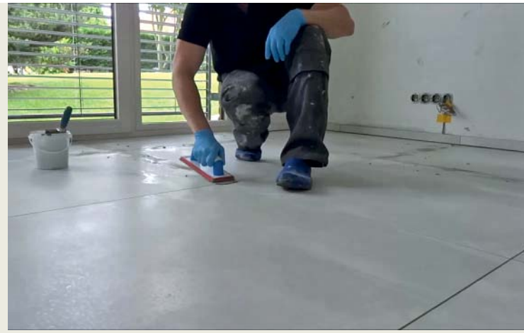
Einfugen eines Reaktionsharzmörtels
