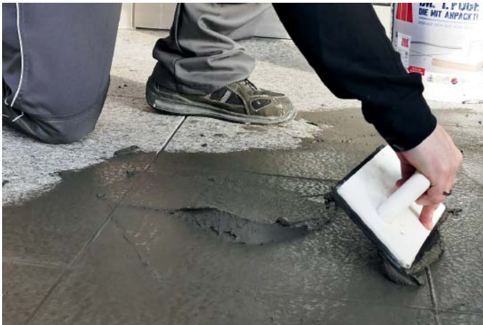
Nahezu vollflächiges Einfugen eines zementären Fugenmörtels
