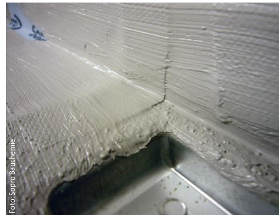
Eine Kunststoff-Zement-Mörtel-Kombination (M) ist als AIV eindeutig definiert.
