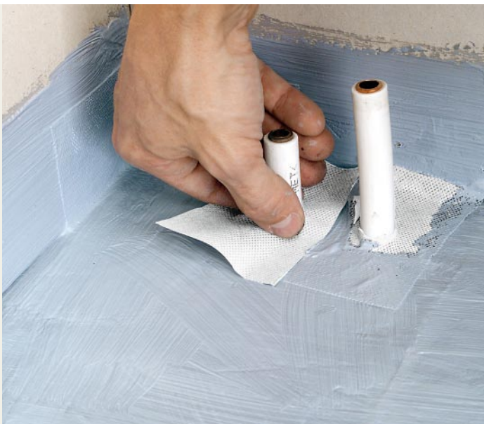
Dichtmanschetten benötigen ausreichend lange Rohrstücke, um an dieses Anschlussdetail sicher angeschlossen werden zu können.
