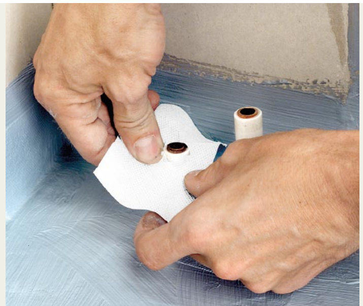
Heute unterliegen Verbundabdichtungen der sogenannten Kitprüfung, die alle Bestandteile einer Abdichtung umfasst.
