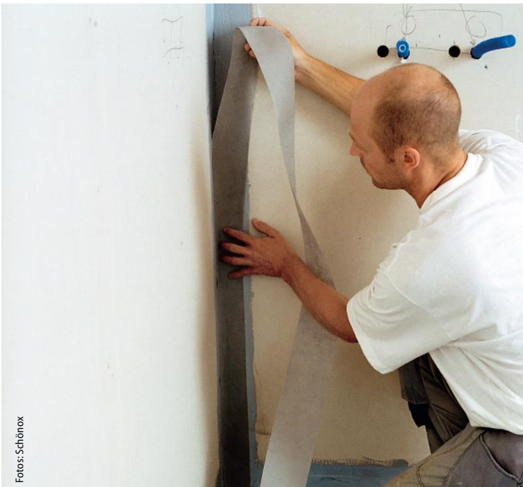
Dichtbänder müssen Einiges mitmachen: der Wasserbelastung in Nassbereichen standhalten, Längenänderungen der Bauteile dank ihrer Dehnfähigkeit unbeschadet überstehen und nicht zuletzt gegen chemische Keulen resistent sein, zum Beispiel gegen die gern verwendeten kalklösenden Reiniger.
