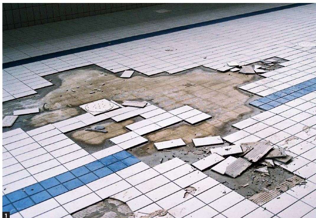
1/2 Kein Einzelfall: Fliesen, die sich vom Beckenboden ablösen.
