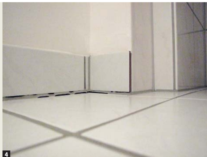
4 Wird die Belegereife nicht eingehalten, kann es selbst bei Calciumsulfat-estrichen zu sonst unüblichen Randabsenkungen kommen.
