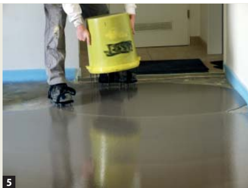
5/6 Spachtelmassen können mit der Stachelwalze fein verteilt werden, um einen ganz ebenflächigen Untergrund zu erstellen.
