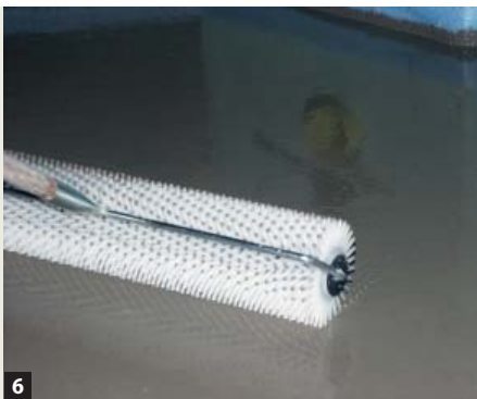
5/6 Spachtelmassen können mit der Stachelwalze fein verteilt werden, um einen ganz ebenflächigen Untergrund zu erstellen.
