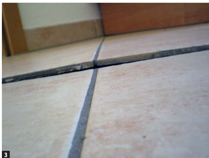
3 Die Kräfte, die ein schwindender Untergrund entfaltet, sind von keinem Verlegemörtel mehr auszugleichen.
