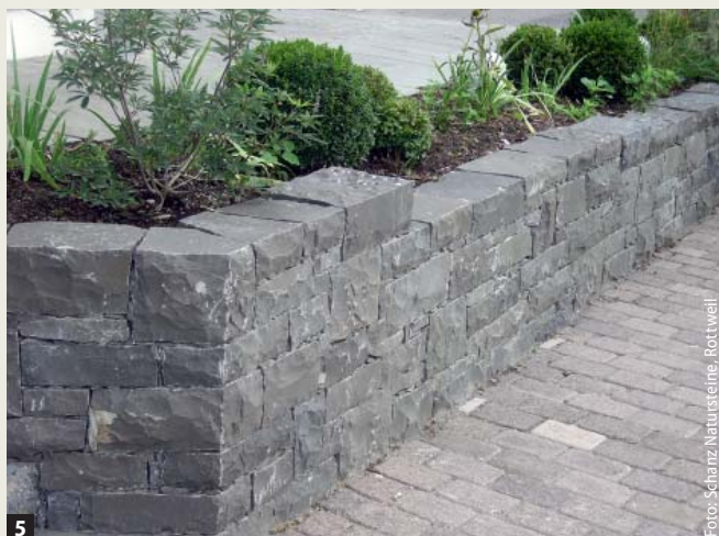
5 Trockenmauern mit der Optik eines unregelmäßigen Schichtenmauerwerks sorgen für eine „geordnete Lebendigkeit“.
