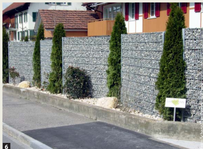
6 Eine Steinhecke benötigt als Einfriedung und Sichtschutz nur minimalen Platz.
