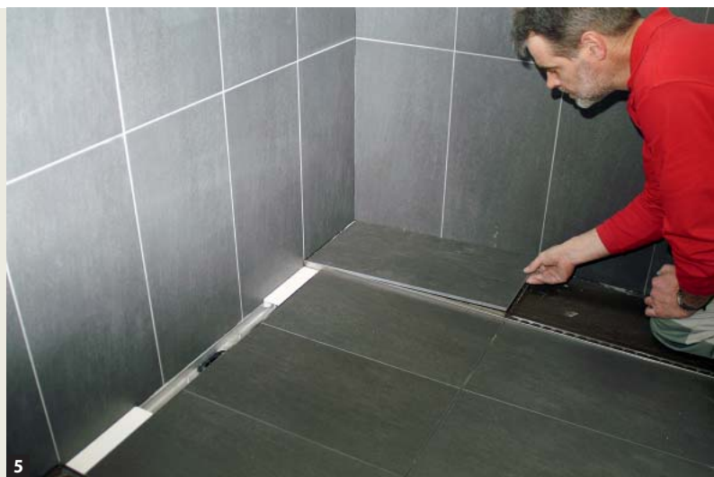
5 Die Linienentwässerung schafft für bodengleiche Duschen mehr Gestaltungsmöglichkeiten bei der Verlegung des Bodenbelags.
